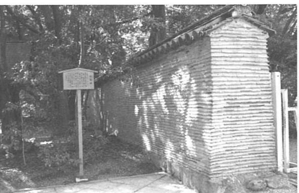
瓦を平積みにして、瓦間の目地には、土と石灰を油で練って、築造しています。
